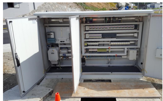
Abbildung 2: Bsp. Feld Abgänge und Steuerung
