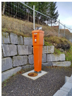
Abbildung 5: Bsp. GSM Notrufsäule
